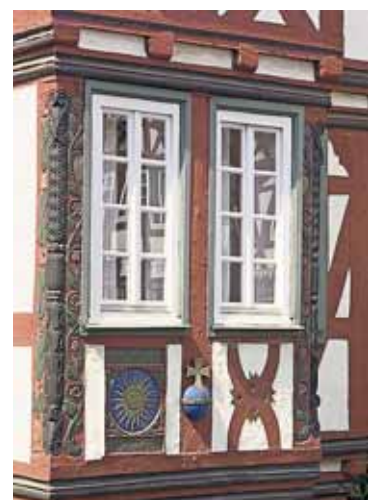
Schön aber aufwändig: Altstadtsanierung
