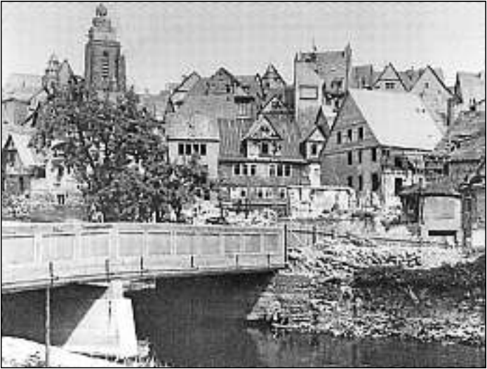
Auch die Altstadt wurde Ziel von Bombenangriffen. Hier Schäden, die im März 1945 in Nähe der alten Lahnbrücke entstanden. Auch am Dom und am Domplatz kam es zu Zerstörungen.
