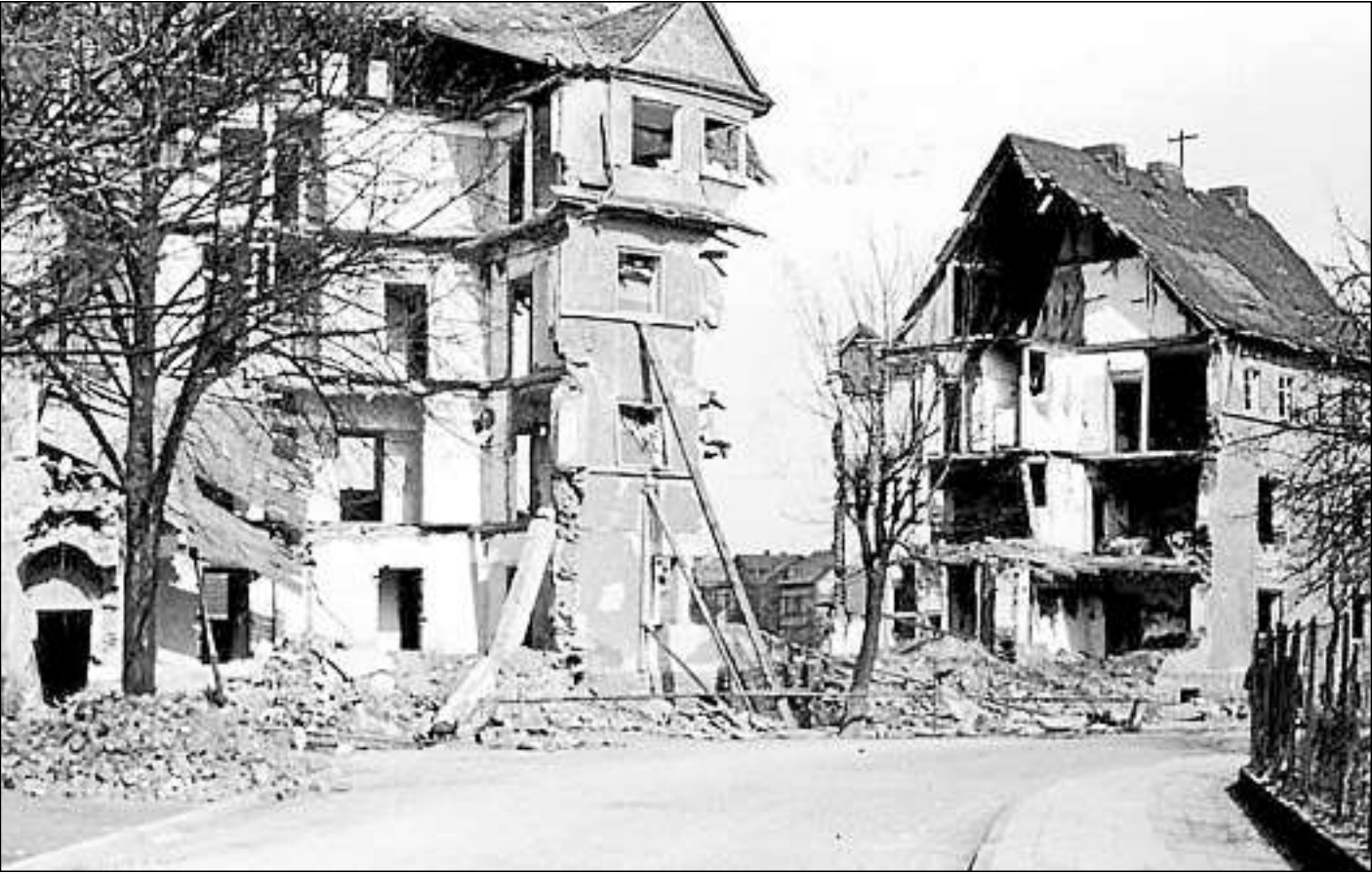
Zerstörungen in der Moritz-Budge-Straße nach den Luftangriffen im November 1944, Aufnahme im April 1946. Insbesondere die Neustadt und Niedergirmes waren Ziele der Luftangriffe.
