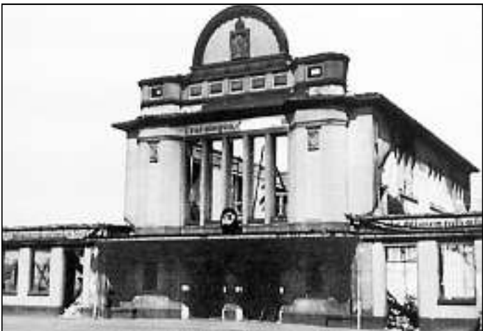
Auch der Bahnhof wurde im März 1945 Ziel der Luftangriffe über Wetzlar. Das Empfangsgebäude wurde dabei völlig zerstört. Halb zu lesen waren noch die Durchhalteparolen „Erst siegen, dann reisen“ und „Räder müssen rollen für den Sieg“.
