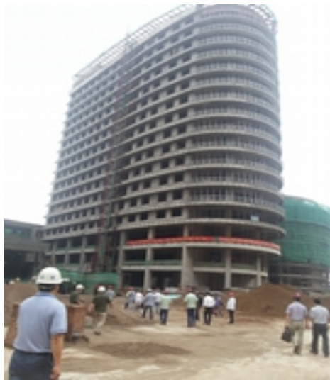
Neubau eines 1500 Betten-Krankenhauses in Chengde, Nord-Ost-China
